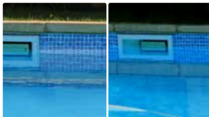
Povrch vně plaveckého bazénu
