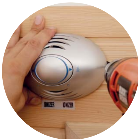
Instalace ionizátoru
